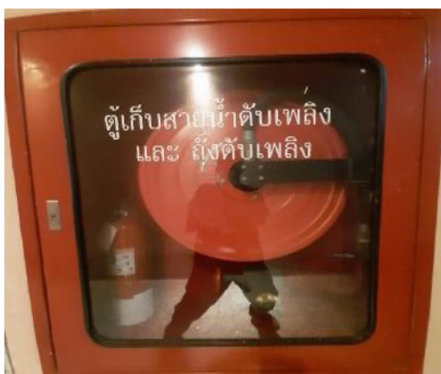
ตู้เก็บสายน้ำดับเพลิง และถังดับเพลิง
