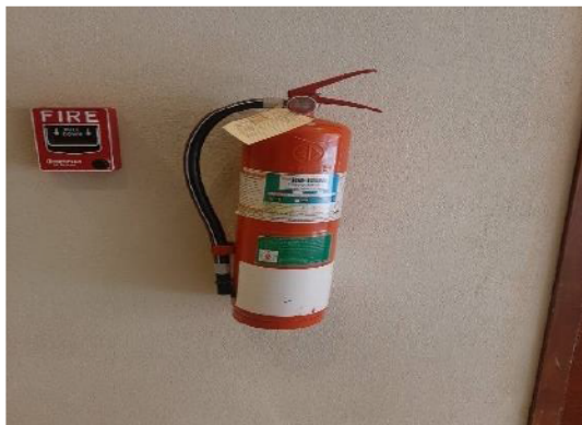
ชุดแจ้งเหตุแบบใช้มือ และถังดับเพลิงแบบมือถือ
